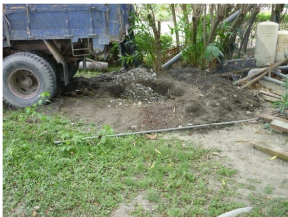
回填級配料及澆置水泥砂漿
