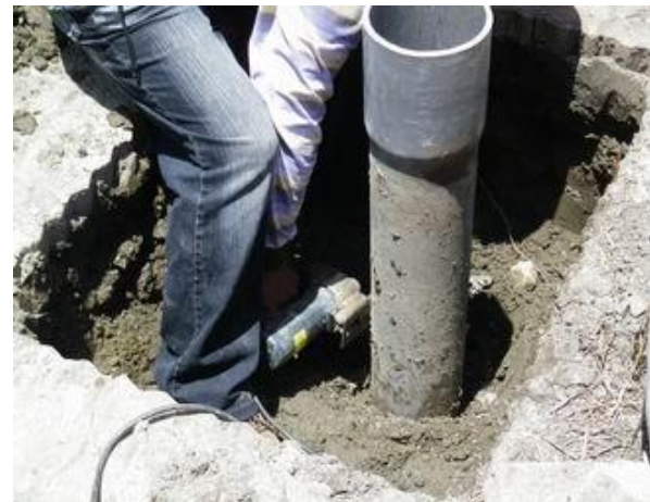
切除水井外管
