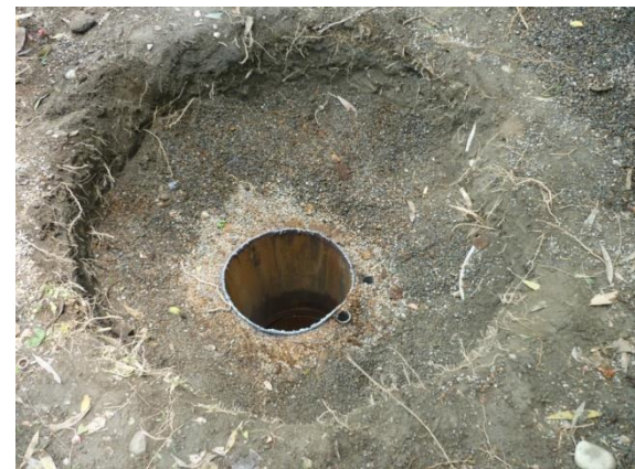
切除水井外管
