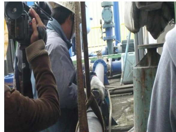
拆除水井外管
