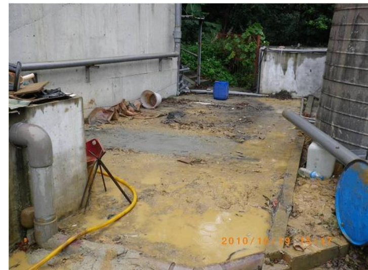
違法水井封填完成
