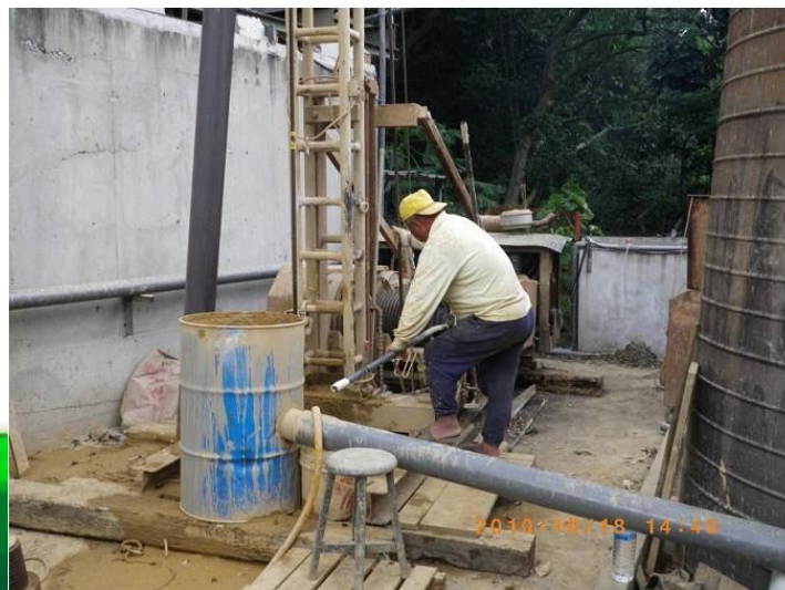
拆除違法水井鑿井機具
